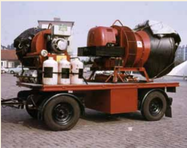
Halverwege de jaren zestig werd het synthetische lichtschuim (Hi-Ex) snel populair en in Amsterdam kocht men twee generatoren, die op een schuimaanhangen (SA-wagen) werden geplaatst op kazerne Teunis.
