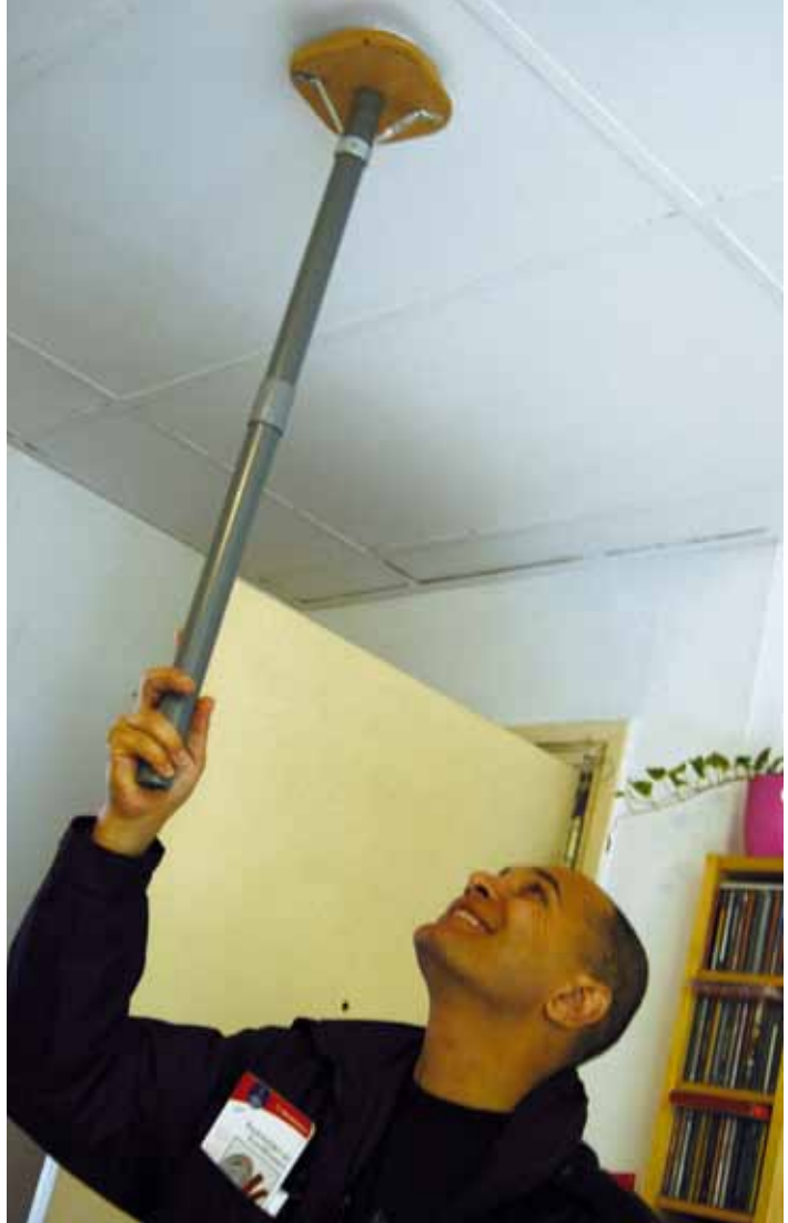
Ambassadeur John Jones hangt een rookmelder op.
