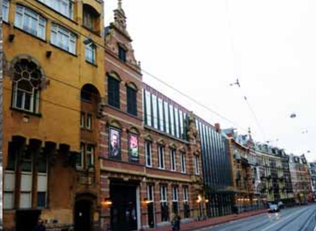
In de gevel van het nieuwe gebouw van het DeLaMar Theater is die van de oude Spieghelschool weer helemaal opgenomen, zoals dat ook vlak na de oorlog met het vorige theatercomplex gebeurd was.
