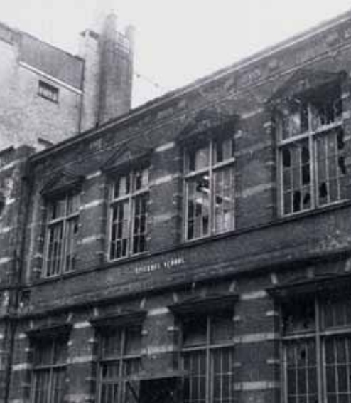
De uitgebrande bovenverdieping van de Spieghelschool na de aanslag van 5 januari 1945. Wat niet verbrandde was wel verzopen door de overijverige brandweer. Foto: NBDC
